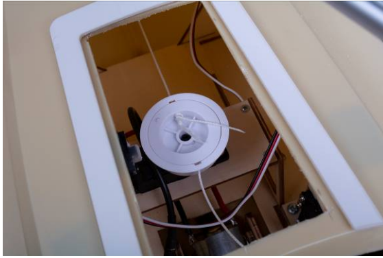
Abb. Segelwinde montiert
